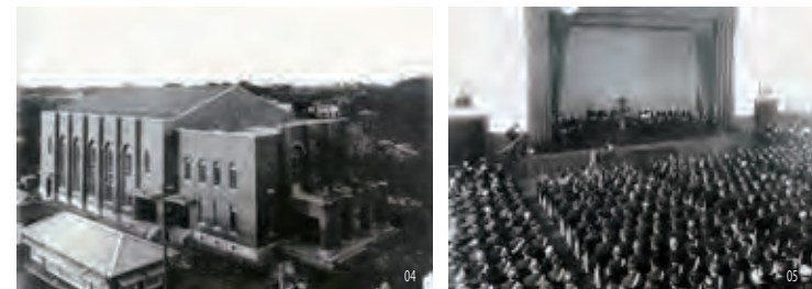
武蔵学園 講堂 1928年竣工 設計：佐藤功一 施工：清水組 MUSASHI GAKUEN Auditorium COMPLETED 1928 Design: Koichi Sato Construction: Shimizu Corporation
