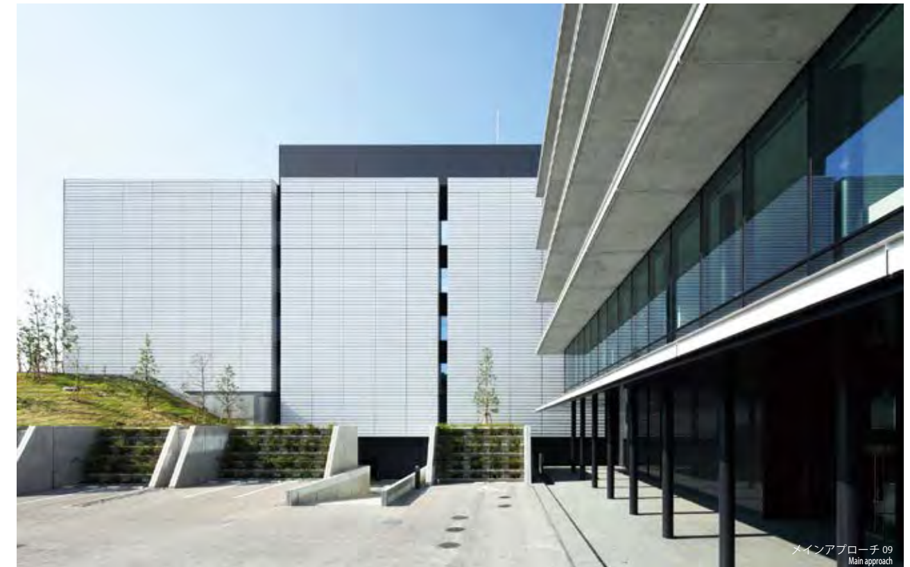
外観全景 08 Overview
