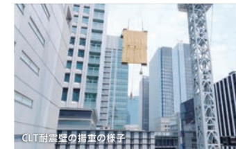
CLT耐震壁の据置の様子
