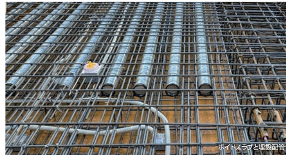
ボイドスラブと埋設配管
