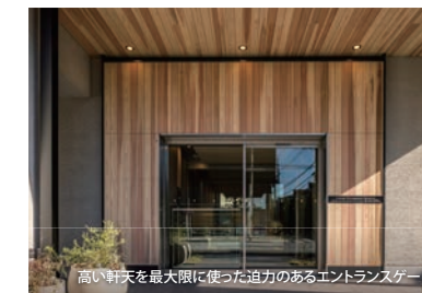
高い軒天を最大限に使った迫力のあるエントランスゲート
