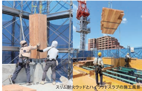
スリム耐火ウッドとハイウッドスラブの施工風景
