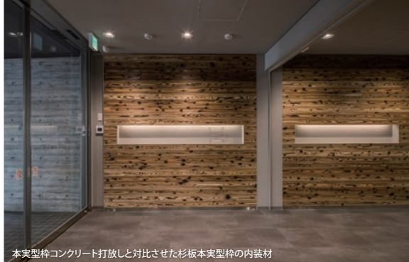
本実型枠コンクリート打放しと対比させた杉板本実型枠の内装材
