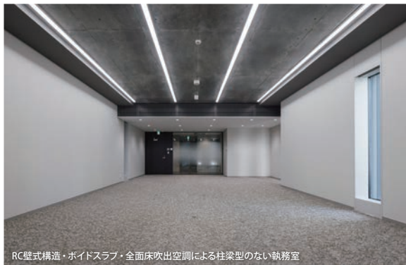
RC壁式構造・ボイドスラブ・全面床吹き出し空調による柱梁型のない執務室
