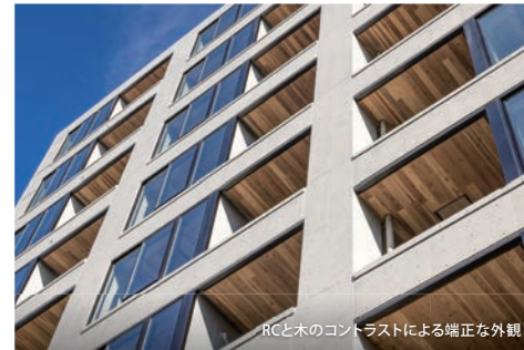
RCと木のコントラストによる端正な外観
