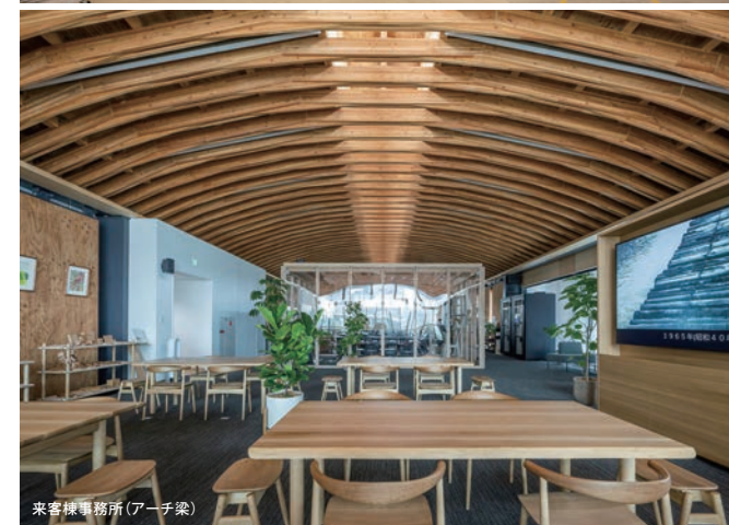
来客棟事務所（アーチ梁）
