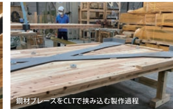
鋼材プレースをCLTで挟み込む製作過程
