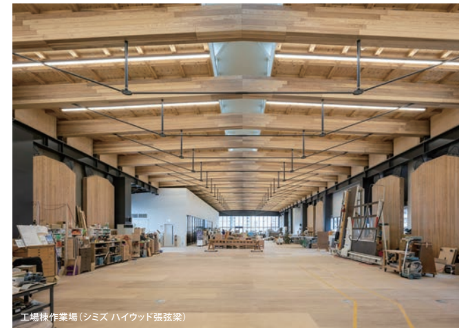
工場棟作業場（シミズ ハイウッド張弦梁）
