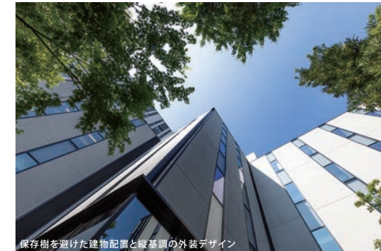
保存樹を避けた建物配置と縦基調の外装デザイン
