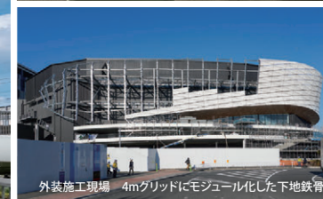
外装施工現場 4mグリッドにモジュール化した下地鉄骨
