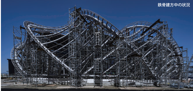
鉄骨建方中の状況
