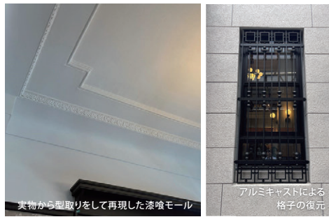
実物から型取りをして再現した漆喰モール
