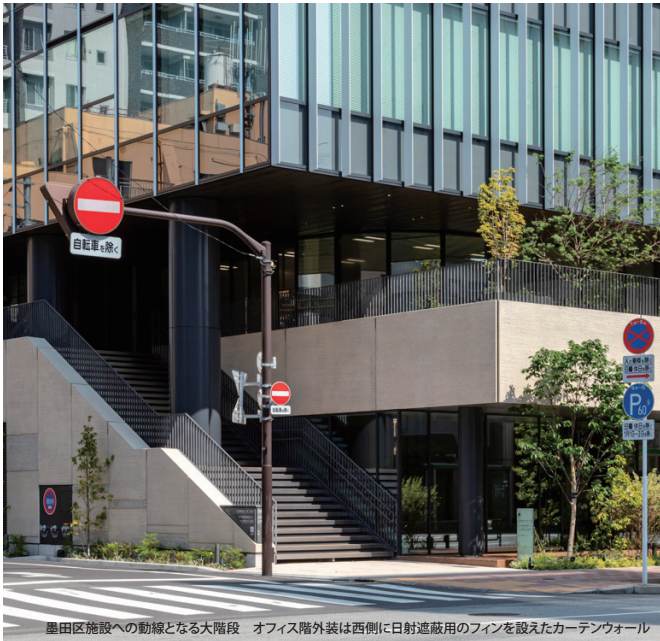
墨田区施設への動線となる大階段 オフィス階外装は西側に日射遮蔽用のフィンを設えたカーテンウォール
