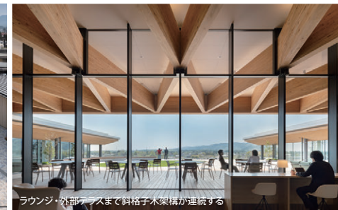
ラウンジ・外部テラスまで斜格子木架構が連続する
