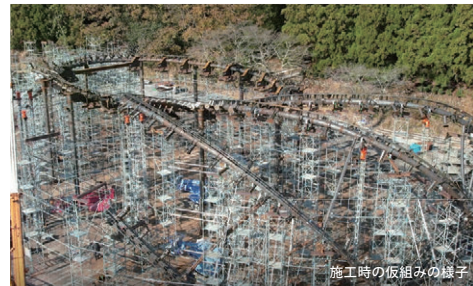
施工時の仮組みの様子
