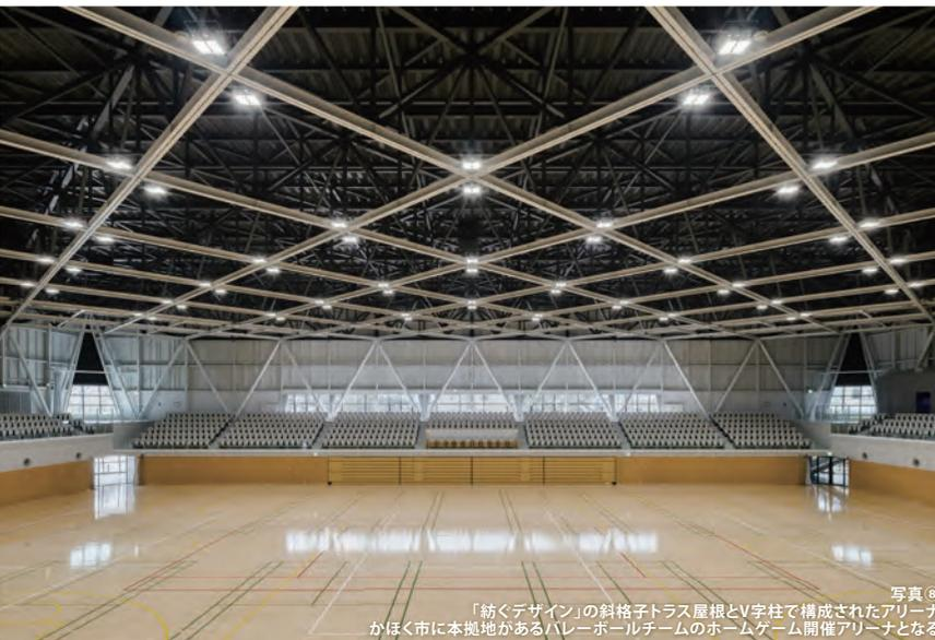
写真⑧ 「紡ぐデザイン」の斜格子トラス屋根とV字柱で構成されたアリーナ
