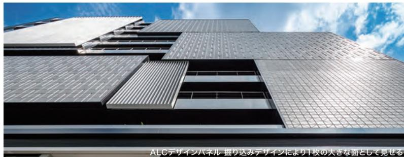
ALGデザインパネル 掘り込みデザインにより1枚の大きな面として見せる
