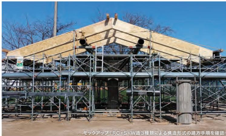
モックアップ：RC・S・W造3種類による構造形式の建方手順を確認
