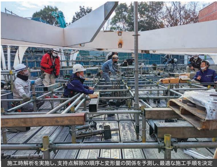
施工時解析を実施し、支持点解除の順序と変形量の関係を予測し、最適な施工手順を決定
