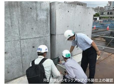
RC打放しのモックアップと外装仕上の確認
