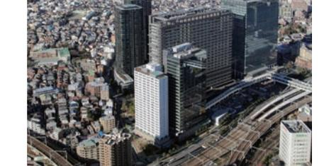
共に暮らし、働き、生きる街「WizCity」と名付けられた大崎駅西口南地区の再開発事業。不整形な歪んだ三角形の敷地中央に業務と住宅のツインタワーを近接させ、寄り添うように建てる。背中合わせで立ち周囲に開く。ボリュームを分節し、群立するタワーの都市景観を形成する。高密に建つタワー周囲にまとまった空地が生まれ、周辺環境とつながる広場を配置する。緑の広場を介して多くの人がつながり、楽しみ、憩う環境をつくった。ツインタワーを載せる基壇は、商業、福祉施設が入り、透けるPC壁で構成される。積層するコンクリートピースによる有孔壁は、外からは壁のように閉じ、内からは程よい開口により採光と眺望を確保している。
