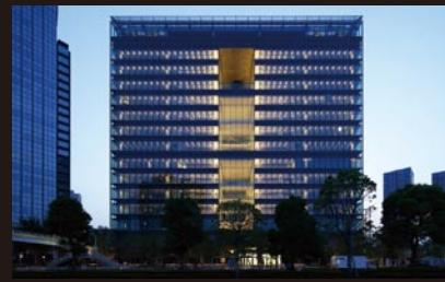
豊洲キューピックガーデンは第一生命保険株式会社が事業主のテナントビルである。建物は間口76m 奥行き89m高さ75mの中層オフィスであるが、最大の特徴はフロア1,500坪のオフィスをテナントオフィスの原則ともいえる無柱空間に拘らず、あえて柱を有し、間口75m奥行き72mを一望できる広大な空間を実現していることである。広大なオフィスはとかく無機的で非人間的なスケールとなりがちであるが、オフィスワーカーが心の拠り所とし安心感を得るスペースをビル内各所に設えている。
