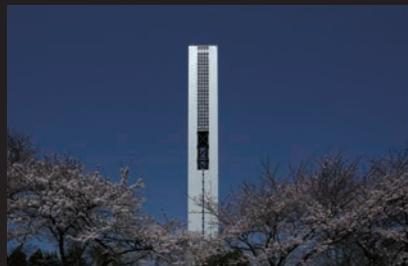
世界的な建築物の高層化、大規模化の進展に伴い、一度に多くの乗客を安全かつ快適に運ぶことのできる超高速・大容量エレベーターの需要が高まっている。(株)日立製作所新エレベーター研究塔はこのニーズに応えるべく超高速、大容量エレベーターの製品開発、及び実証実験を行う目的で計画された研究施設であり、2010年4月に完成した。建築物の最高高さは213.5mでエレベーター研究塔としては世界一の高さとなる。躯体はRCコアウォールをSRC造の境界梁と鉄骨ブレースで連結させたハイブリッド架構とし、風にも地震にも強い構造とした。低層棟を高層棟の両脇に配置することでアウトリガーの機能を持たせている。アスペクト比10のスレンダーな外観を維持し、尚且つ建築の機能的スペースを最大限に確保する為に、平面形状を敢えて空力的に不利な隅切りの無い矩形に挑戦した。これを実現するために、地上110mから140mに風孔を設け、暴風時のタワーの揺れを効果的に低減させることに成功している。
