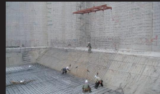
円筒基礎は約18,000m<sup>3</sup>のコンクリートで充填される基礎配筋中の円筒状基礎
