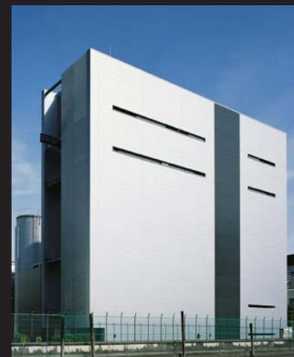
生産技術の高度化に伴い、信頼性の高いクリーン環境の実現は、生産プロセスの要となっている。本施設は、顧客企業と密接な連携の元、最適なクリーン環境を迅速かつ確実に実現するための実験・検証施設として計画された。この実験棟は、スーパーナノクリーンルーム・モックアップクリーンルーム・バイオロジカルクリーンルームの3種類のクリーンルームを備えている。
