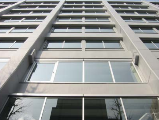
中間階免震部の外観
