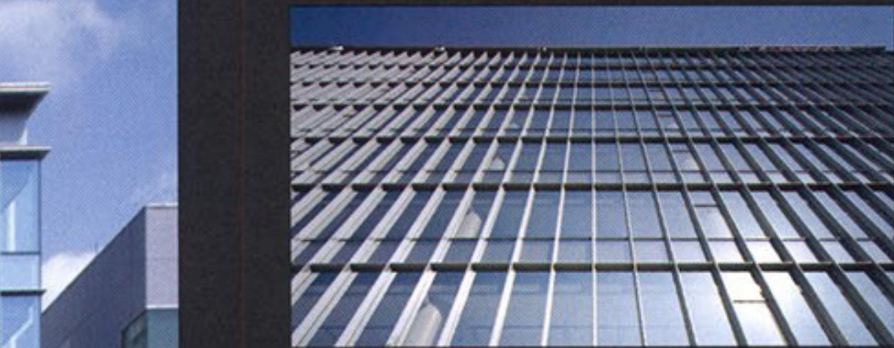
収益面積の大きさに応じて工事費を算出するという、第一生命のこれまでにない取組みに対応して84%という究極のレンタブル比を獲得したオフィスである。外壁率の低い立方体形状と、仕切り自由度の高いカーテンウォールモジュール・設備モジュールを有する平面計画を追及した。ファサードはモダンな3層構成とし、基壇は列柱胴部は日射低減を図った150mmの見込みの外部フィンと透明系反射ガラスのミニマムなカーテンウォール、頂部はテナントロゴの配される彫りのある冠パネルとした。賃貸ビルのプロトタイプとしてのシンプルで率直な計画により、オーナーの持つ三田の敷地へのこだわりに応えた。
