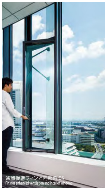
ビルが風を受けた時のファサード面の風圧のゆらぎ、窓毎の風圧差により通風を促進する Fluctuations in wind pressure on facade surface when wind strikes the building
