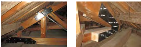
小屋組みの補強 Roof truss reinforcement
