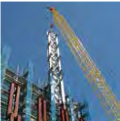
外壁と一体となった組柱の建方 Erection of integrated outer wall and connected columns
