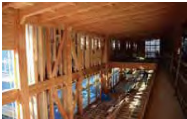
高耐力筋かいを使用した開放的な空間 Open environment created using large load-bearing capacity braces
