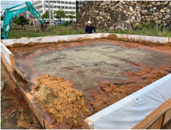
6/末に製作した荒壁土の2回目の練り返しを行いました。練り返し前の状況です。
