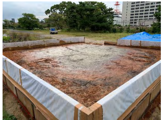
6/末に製作した荒壁土の2回目の練り返しを行いました。練り返し前の状況です。
