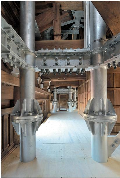
上・清水建設による耐震補強後の、西新井大師山門内部。既存の木造部分への影響を最小限に抑えた位置に鉄骨構造を新設し接続することで耐震性を高めた。下・西新井大師山門の保存修理と耐震工事では、境内側に新たな基礎を設置し、曳家(水平移動)することで、門前の拡張整備も実現した(2点撮影・NARU建築写真事務所 中塚雅晴)
