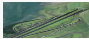
新東名高速道路川西工事 (完成イメージ)
