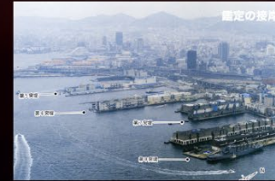
手前の第8突堤には、補給艦「とわだ」が横づけして給水支援をしている。
