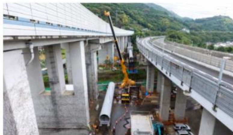
Actual construction site
