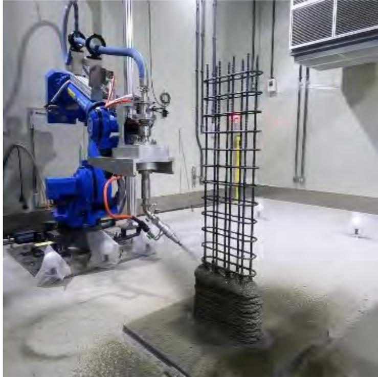
鉄筋の外周から材料を吹きつけて内部へ充填
