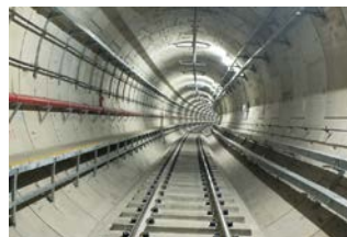
MRT南北線工事にて、インドネシアで初めてシールド工事を完成
