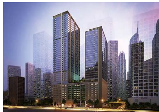
設計施工で受注した超高層複合開発「メガコンガンプロジェクト」に着工
