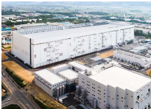
キオクシア岩手株式会社 510棟 (CR棟) 新築建築工事 発注者：キオクシア株式会社
