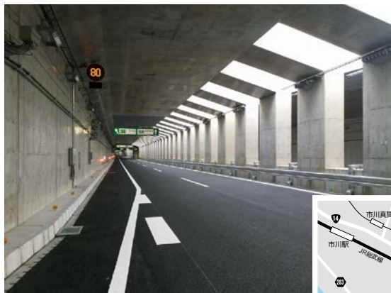
完成した外環道本線
