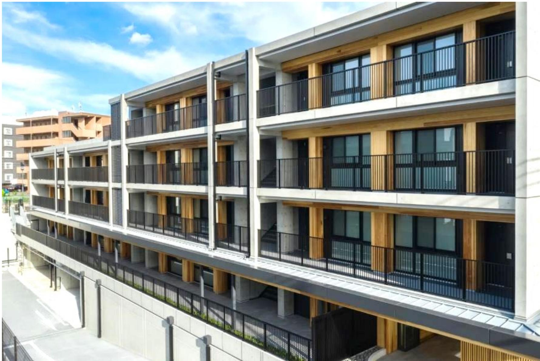
木質構造と鉄筋コンクリート造のハイブリッド構造（スリム耐火ウッド）
