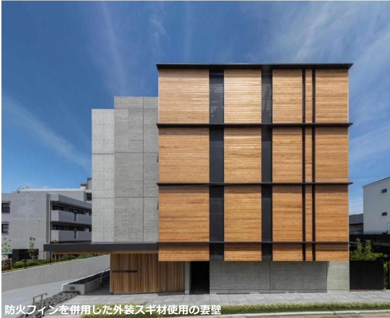
防火フィンを併用した外装スギ材使用の妻壁
