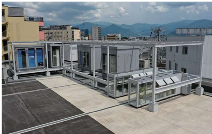
Hydro Q-BiC 設備設置状況
