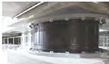
地震動対策(免震) (用途・規模に応じた多様な免震)
