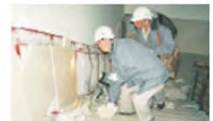
被災度判定 (構造物、設備、外装、内装)
