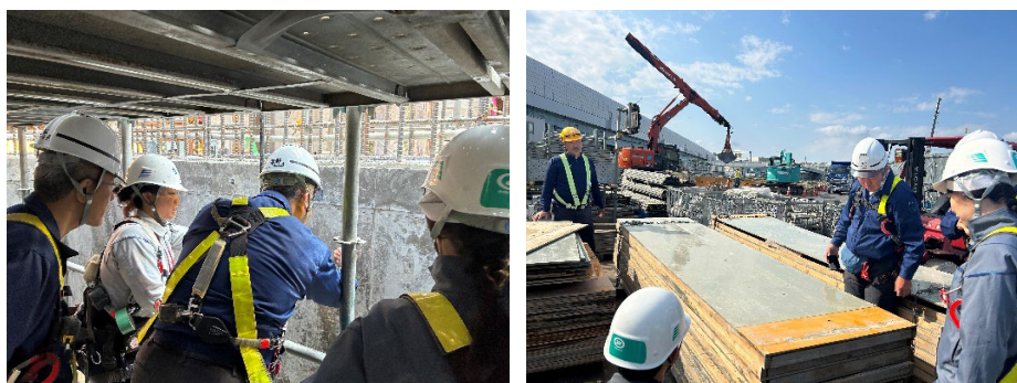
写真 4 当社施工現場における国産材型枠合板トライアルの様子
