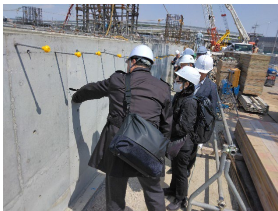
画像 1 自社施設施工現場における国産材型枠合板トライアルの様子
