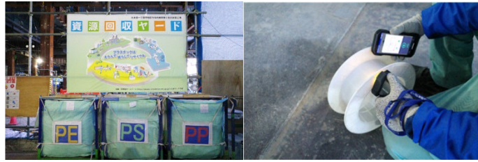
(左)資源回収ヤード、(右)廃プラスチックの材質確認 画像 4 ヤード及び各工程での様子
