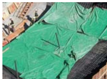
グリーンシートで作業中の構造物を覆う作業
