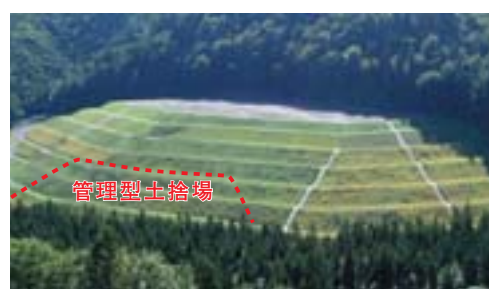
八甲田トンネルの管理型土捨場。鉱化変質岩に対する環境対策を行いました。
