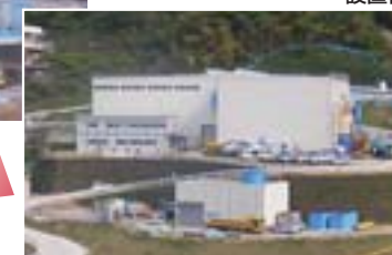
坑口全体を覆う防音ハウス
