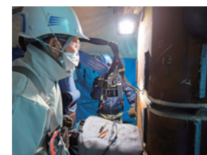
資材の水平搬送ロボット「Robo-Carrier」(上)と溶接ロボット「Robo-Welder」(下)
