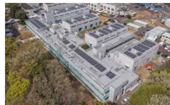
改修工事によりZEBを達成した産業技術総合研究所 研究施設(茨城県つくば市)
