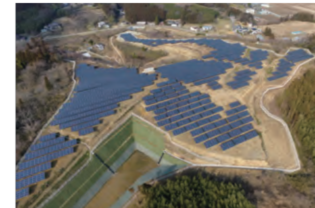
宮城登米太陽光発電所(宮城県)
