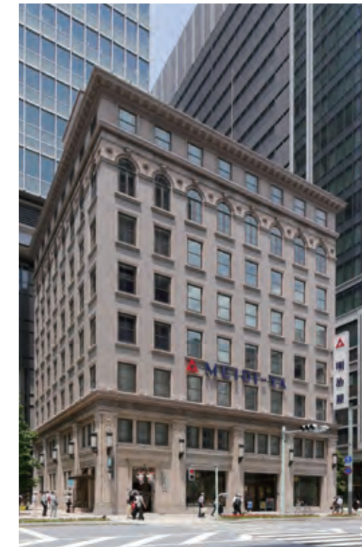
明治屋 京橋ビル (設計施工:当社 共同設計:U.A建築研究室)
