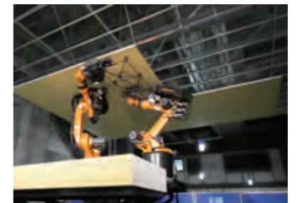
天井を施工する「ROBO-BUDDY」
