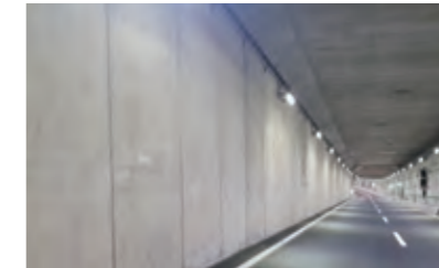
ハイブリッドハーフプレキャスト構造による大断面ボックスカルバートの省人化・省力化(東京外環自動車道 京葉ジャンクションAランプ)
