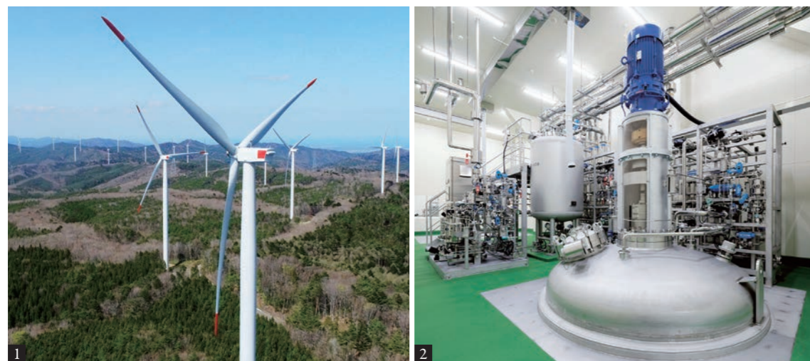
1 阿武隈風力発電所 (第一～第四発電所) (福島県・2025年)
