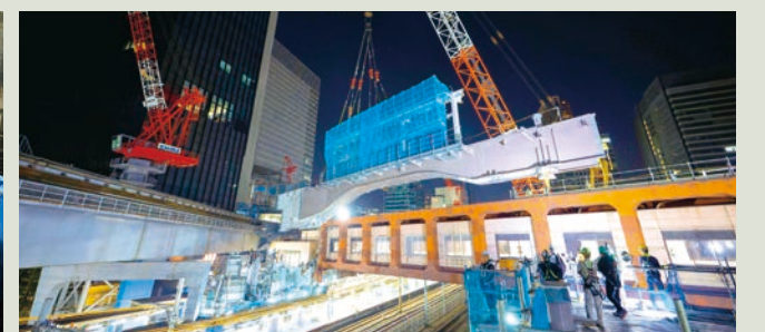
自由通路工事での線路上における桁架設状況
