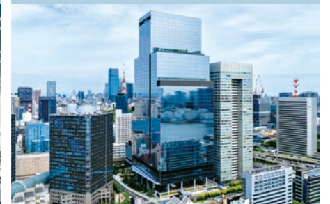
竣工した建物外観
