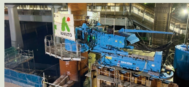
護岸再構築工事でのジャイロプレス施工状況
