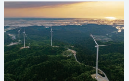
初適用となった中里風力発電所（写真提供：Studio Quaria）
