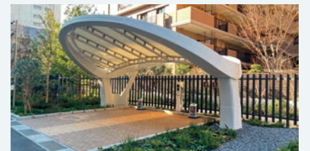
駐車場の屋根構造物（温故創新の森NOVARE）
