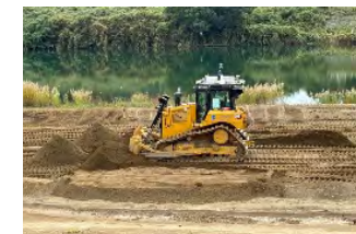
自律施工するSmart Dozer®
