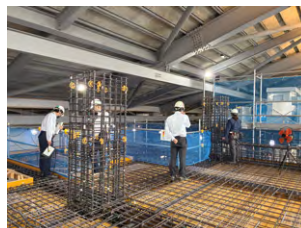
モックアップを利用した配筋検査研修
