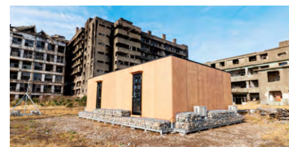
56年ぶりとなる新建築物「72号棟」外観
