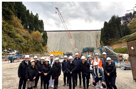
建設中の足羽川ダム(福井県)を視察
