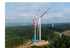
建設工事におけるSMTC施工の全景
