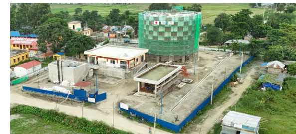
ビラトナガル上水道改善計画（ネパール）
