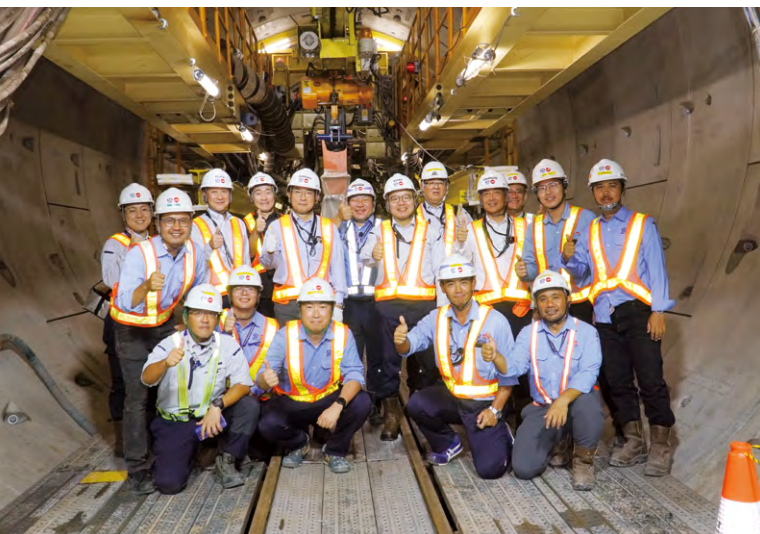
ジャカルタ地下鉄 南北線延伸2期 CP202工区の視察風景
