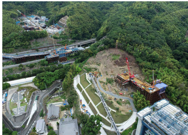
梶原トンネル工事 日本の新たな大動脈、新名神を建設中(大阪府高槻市)
