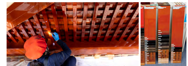
久志間切弁柄の塗装。外部塗装は最も多い箇所です27の工程がある
