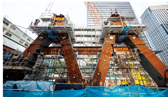
建設中の Torch Tower ダイヤグリッド架構 (東京都千代田区) 2025年8月時点
