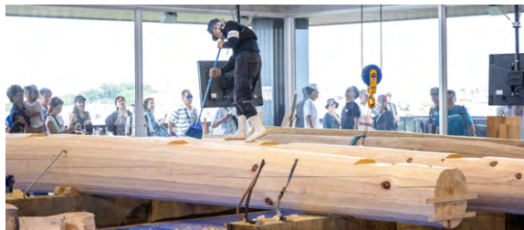
来園者が伝統技術を間近で見られるコーナーを設置(写真は小屋丸太の手斧仕上)
