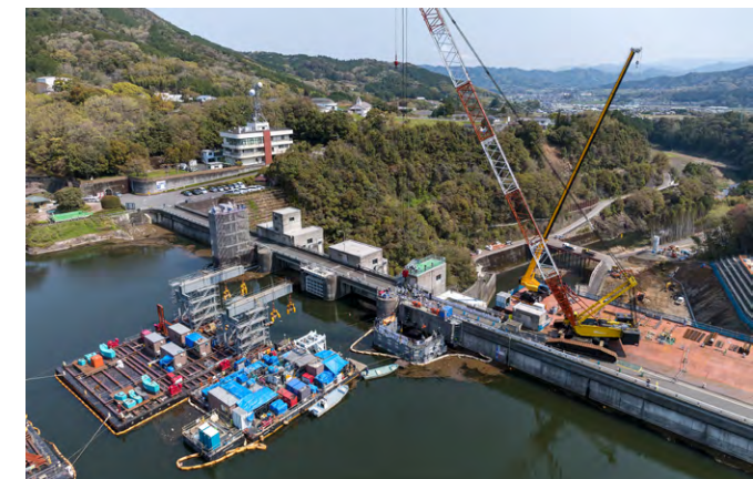
野村ダム改良工事 浮体式上流仮締切を水面に浮かべて施工(愛媛県西予市)
