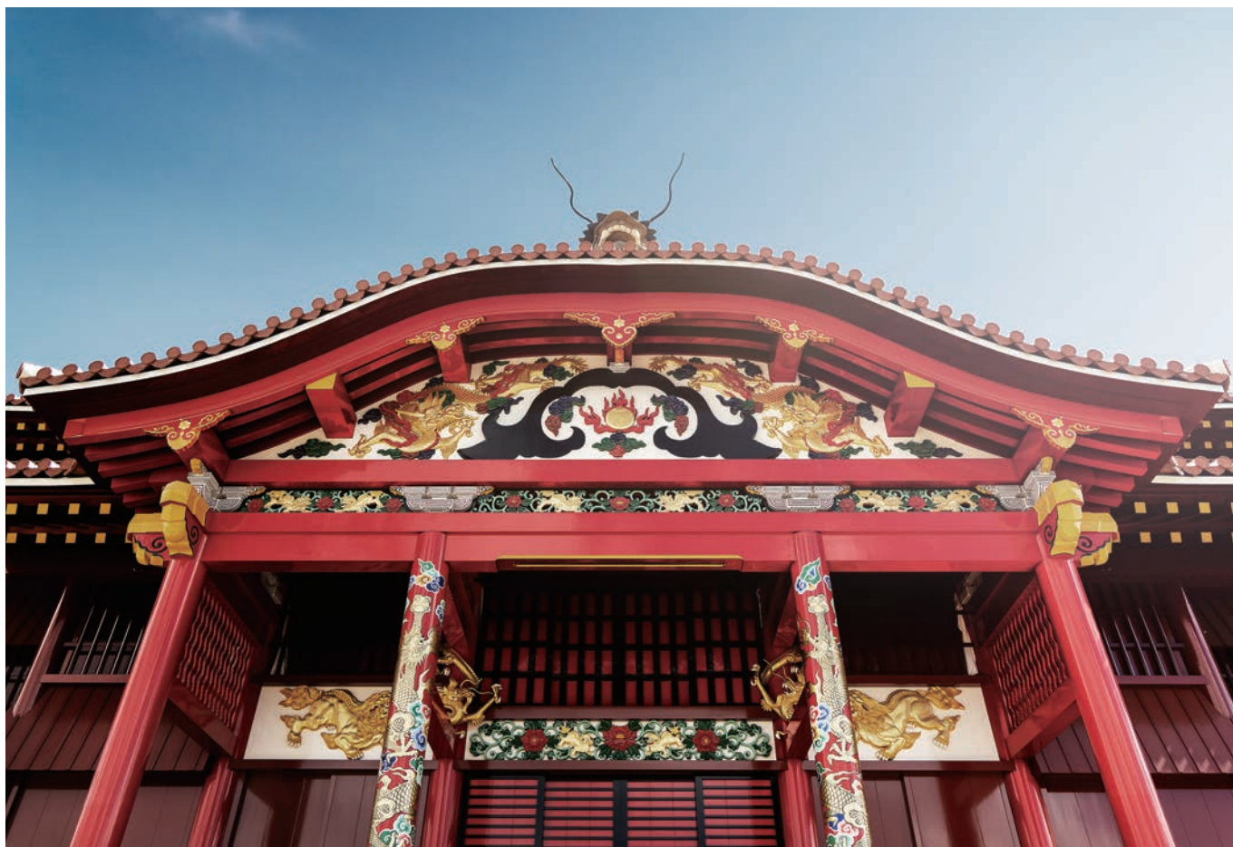
首里城正殿復元整備工事
