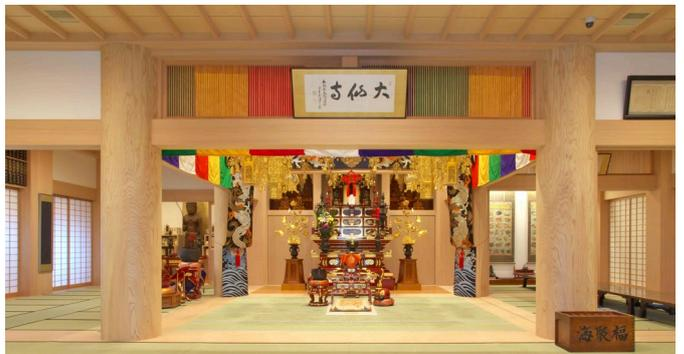
寺院の本堂・客殿・庫裏の新築。本堂基壇部分（1階）を客殿として効率的で使い勝手の良い建物としています。RC造ながら内部柱には秋田杉の円筒打込み型枠を採用し、木肌の美しさを現した柔らかな空間を実現しています。
