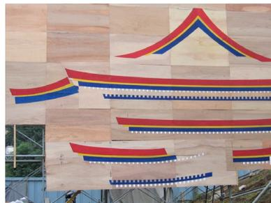
現寸図による軒反りの確認
