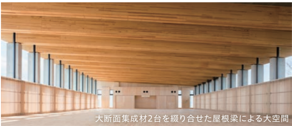
大断面集成材2台を縦り合せた屋根梁による大空間
