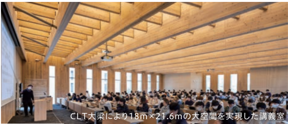
CLT大梁により18m×21.6mの大空間を実現した講義室
