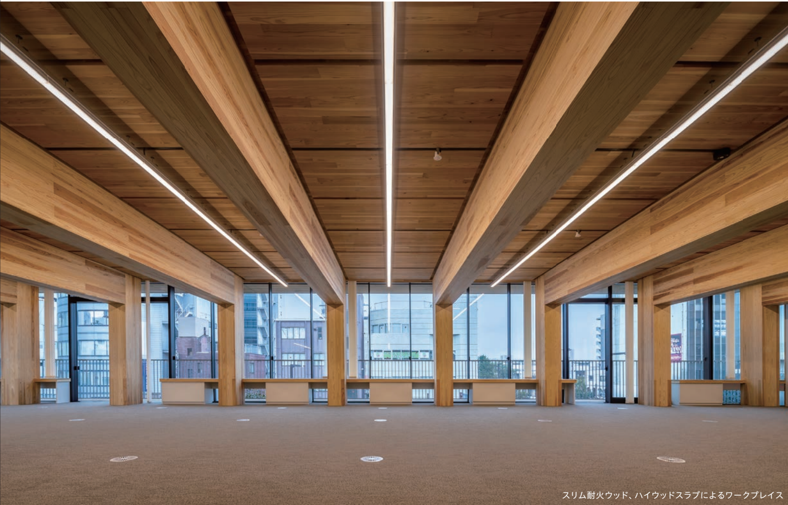
スリム耐火ウッド、ハイウッドスラブによるワークスペース
