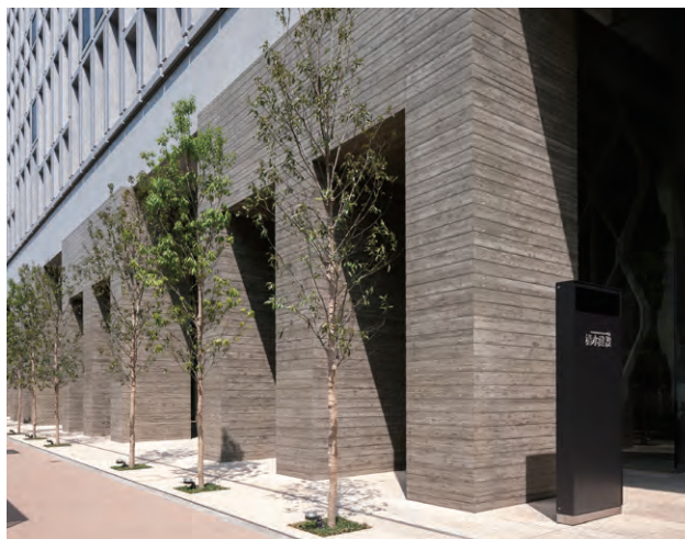
清水建設 本社
