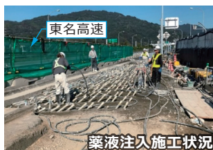
薬液注入施工状況
