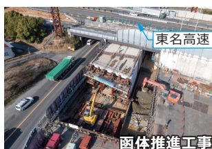
函体推進工事
