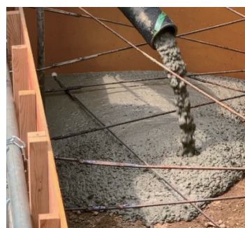
圧送後のコンクリート状況
