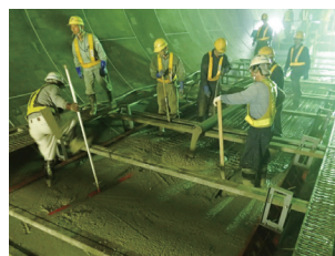
インバートコンクリートの 長距離圧送状況
