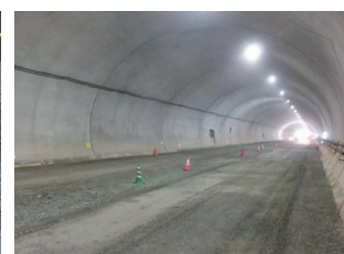
コンクリートの打重ね部
