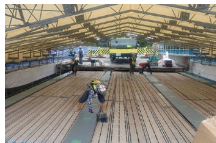
全天候型ドーム使用時のフランジ処理
