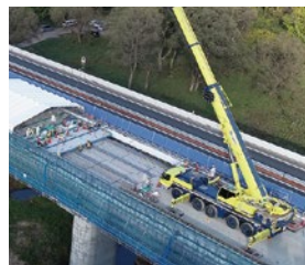
クレーン架設 (東日本高速道路株式会社 磐井川橋床版取替工事)
