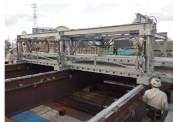
合成桁用床版架設機 (阪神高速道路株式会社 3号神戸線神下S391橋梁)
