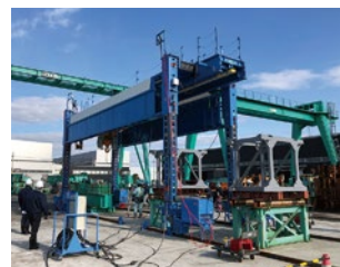
半断面架設機 (中日本高速道路株式会社 菅ヶ谷高架橋床版取替工事)
