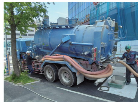
従来の流動化処理土施工と同じ運搬車を使用
