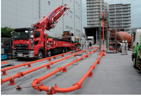
ポンプ圧送状況
