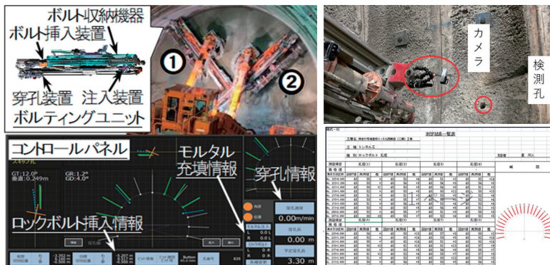
コントロールパネル 穿孔径の取得状況と帳票 2ブームロックボルト打設専用機
