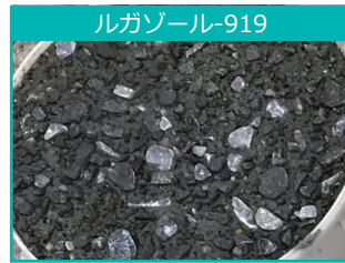
洗出し状況（打込み直後に散布）
