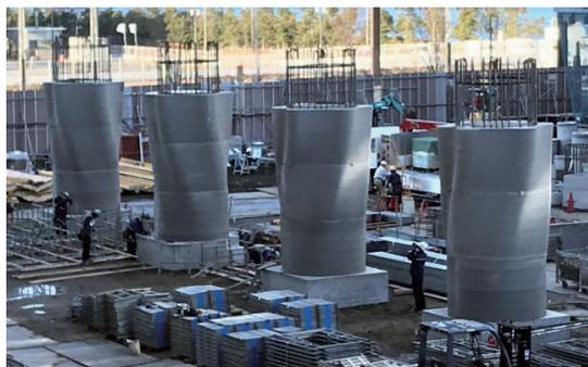
コンクリート打ち込み後の柱部材
