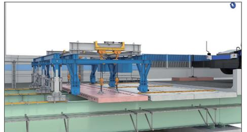
⑨設置箇所のレール撤去後、床版を降し、引き寄せ、HSPJにプレストレス導入
