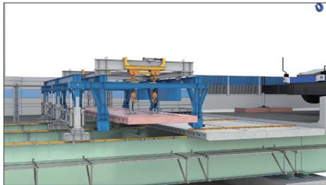
⑧床版架設機により床版3枚目を吊り上げ、設置位置まで運搬
