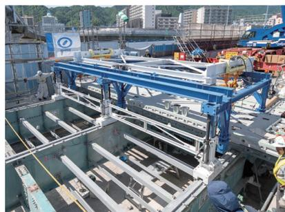
床版架設機で床版を吊り上げて運搬
