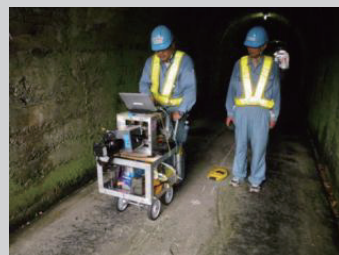
小断面トンネル
