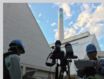
鉄筋コンクリート製煙突
