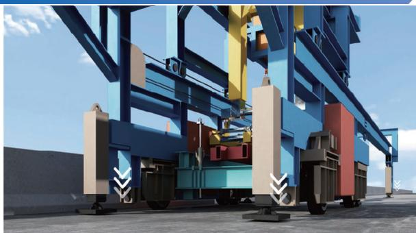
仮置きした床版はく離装置を回収し、架設機をジャッキダウンして次の施工位置へ移動します。②～④を繰り返します。
