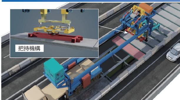
新しい床版を搬入後、把持装置により姿勢を制御しながら床版の架設を5回繰り返します。
