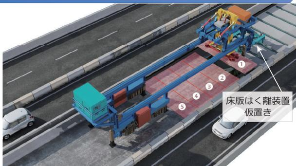
床版はく離装置を施工箇所の外に仮置きした後、床版を把持装置で撤去し、車両の荷台に積み込んで搬出します。
