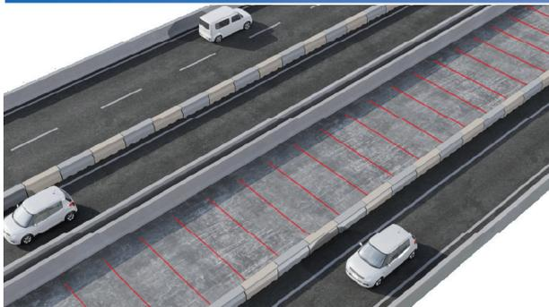
道路規制後、舗装を撤去し、既設床版を橋軸直角方向に切断します。
