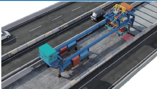
所定の施工位置まで架設機を移動させてジャッキアップし、架設機を固定します。
