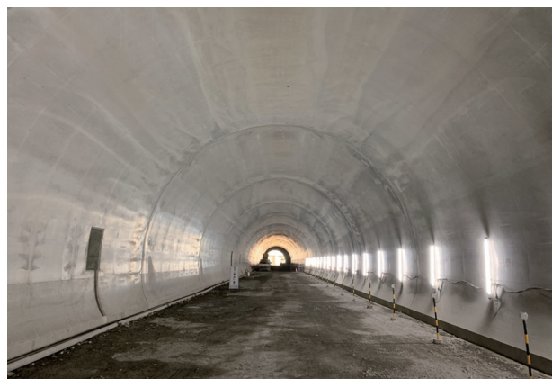
覆工コンクリート（出来形）
