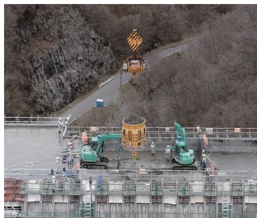
ケーブルクレーンで打設位置に運搬
